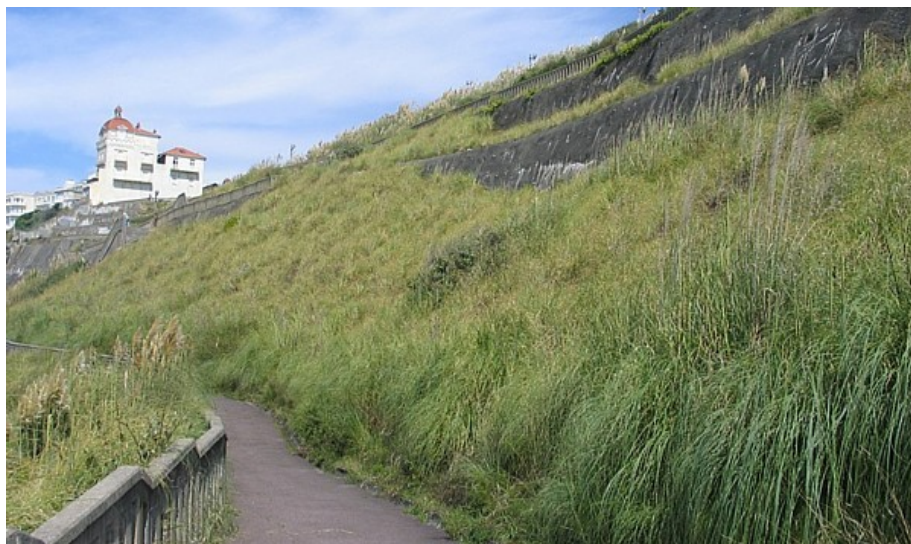
Idem au centre : surface occupée à 100%
