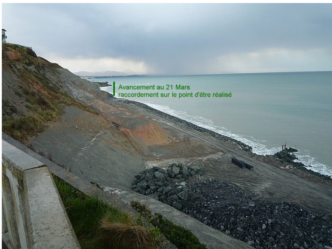
Vue générale : le chantier est très avancé et proche de la jonction avec les blocs de la zone de la Résidence Eugénie
